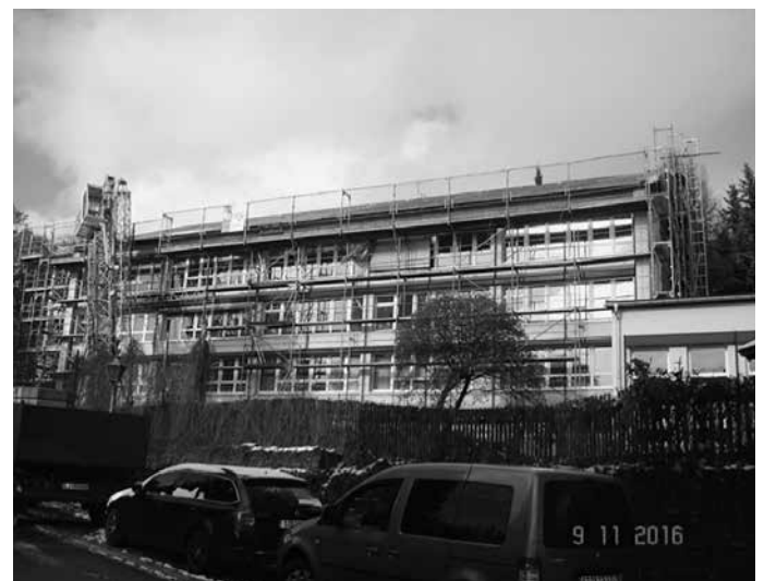
Nach den Abbrucharbeiten laufen derzeit im Gebäude die Sanitär-, Heizungs- sowie Trockenbauarbeiten. Die Südseite des neuen Satteldaches erhält eine Photovoltaikanlage.
