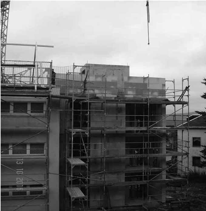
Für einen barrierefreien Zugang zu den Arztpraxen erhält das Gebäude einen neuen Anbau mit einem Personenaufzug.
