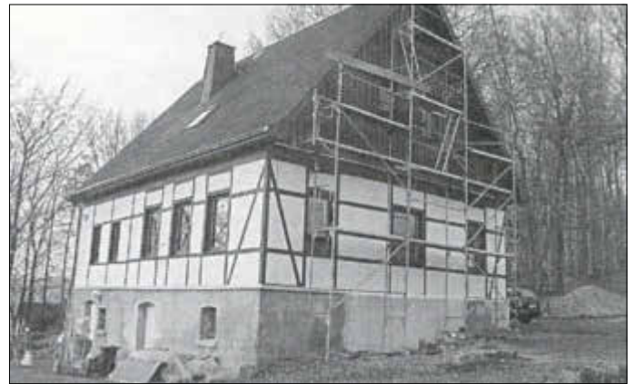
Die Fassade kurz vor der Fertigstellung. Am Giebel wurde jetzt noch eine Schießscheibe als Symbolik angebracht.
