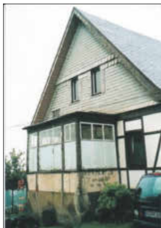
Abriss maroder Anbau.
