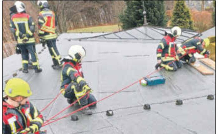
In Beierfeld musste ein Dach gesichert werden, da eine Windböe die Dachbahnen anhub und es abzudecken drohte.
