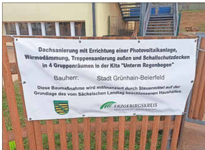
Energie vom Dach liefert die neue Photovoltaikanlage.
