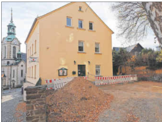
Die letzten Arbeiten sollen 2022 abgeschlossen sein.
