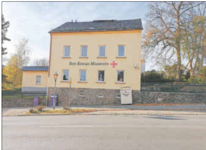
Die Baumaßnahme umfasst auch den Austausch der Fenster.
