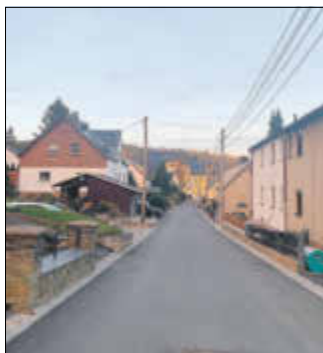
Die Baumaßnahme wurde nach über einem Jahr Bauzeit im September 2022 abgeschlossen.
