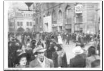
Die notdürftig reparierte Fassade des Messehauses „Handelshof“ 1950.
