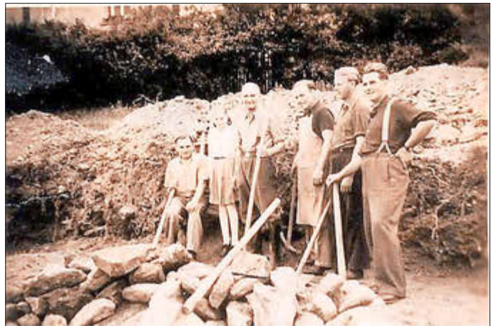
1951 konnte mit der Wiederinstandsetzung der Sportanlage an der Ernst Thälmann-Straße begonnen werden. Alle diese Arbeiten konnten 1953 abgeschlossen werden. Das Foto zeigt v. l. n. r. sitzend: Erich Seifert,?, Martin Hahn,? und „Harty“ Morgenstern bei Arbeiten zur Verbreiterung des Sportplatzes.
