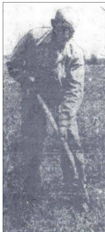
Ein Gemeindevertreter führte den ersten Spatenstich für das Waldbad in Beierfeld aus.
