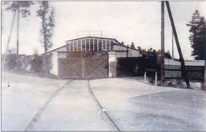
Gleisanschluss der Firma Otto Wolff aus Leipzig in den 50er Jahren des 20. Jh.
