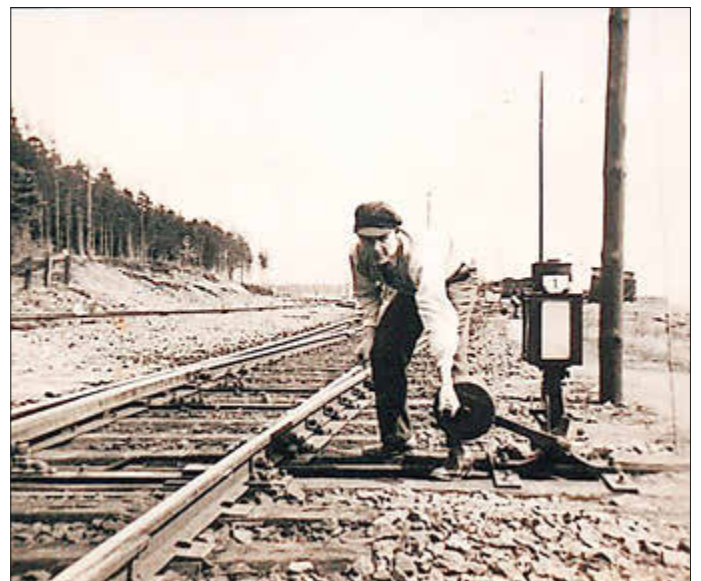
Gleisanlage 1929, Bahnhofseinfahrtssignal Beierfeld aus Richtung Zwicknitz.
