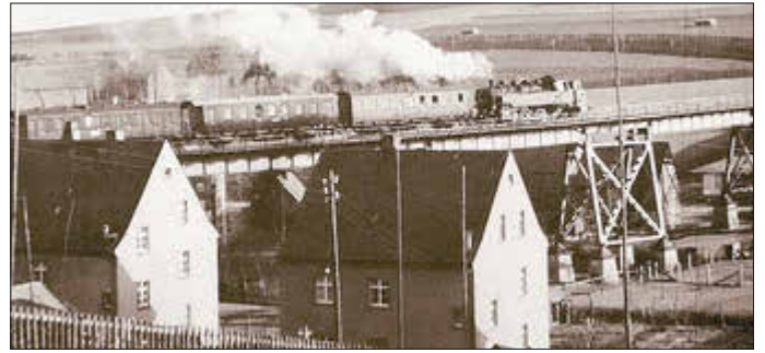
Die Stadtbrücke Grünhain Ende der 30er Jahre. Vor diesem Personenzug ist eine Lok der Baureihe 86. Diese Loks waren ab 1935 bis ca. 1940 auf der Strecke. Ihre Höchstgeschwindigkeit lag bei 80 km/h und sie hatten eine max. Zugkraft von 10,9 t. Ihre Leistung betrug ca. 900 PS. Erstes Baujahr 1927 (Foto H. Hennig)
