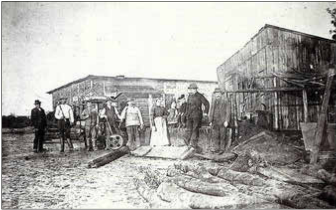
Bahnbauarbeiter. Die Schuppen dienten zur Aufbewahrung der Gerätschaften und Materialien, auch waren eine beachtliche Anzahl von Kantinen entlang der Bahnstrecke vorhanden. Foto: Sammlung Siebenhüner
