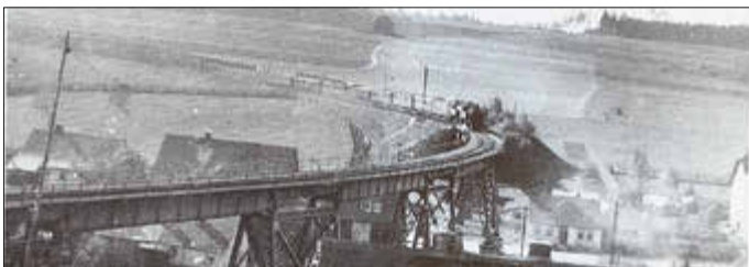
Von Beierfeld nach Grünhain vor der Stadtbrücke ca. 1935. (Foto E. Arnold)
