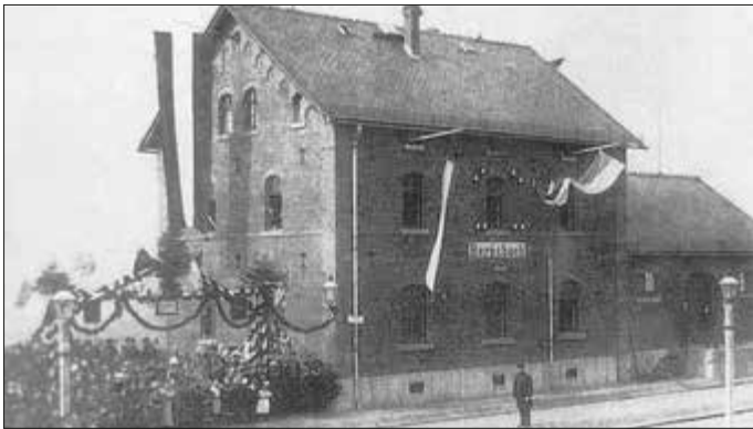
Das Empfangsgebäude in Bernsbach in roter Ziegelbauweise zur Bahnweihe am 30. April 1900.
