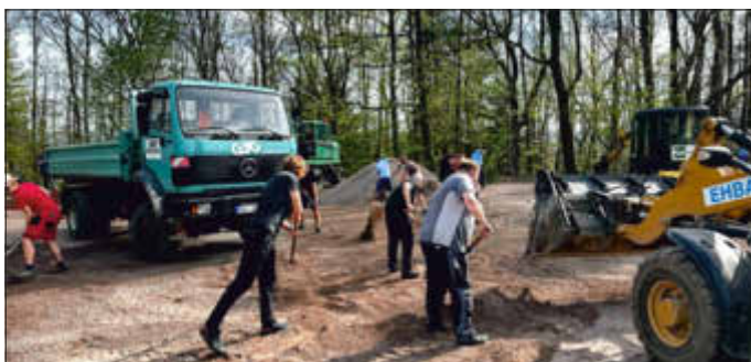
Auf dieser Baustelle klappte alles.
