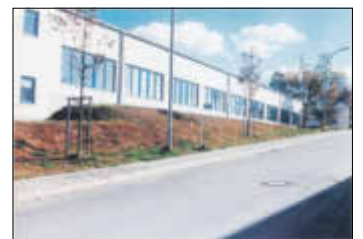
Ausdruck dieser erfolgreichen Entwicklung ist auch der im Zeitraum 1998 bis 1999 errichtete Neubau einer Produktionshalle im Gewerbegebiet am Bockwald.
