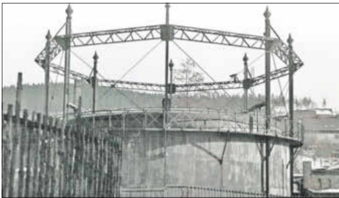
Der Gasbehälter zwischen 1952 und 1960.
