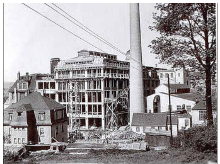
Bau des neuen Fabrikgebäudes der Firma Hermann Nier an der Heinrich-Heine-Straße im Jahr 1928.
