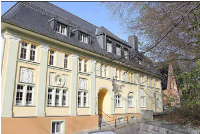
Das Technikzentrum im Jahre 2017.
