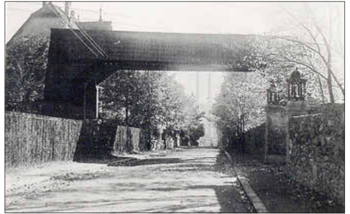
Schutzbrücke über die Frankstraße.
