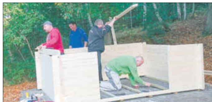
Das neue Gerätehaus in der Bauphase.
